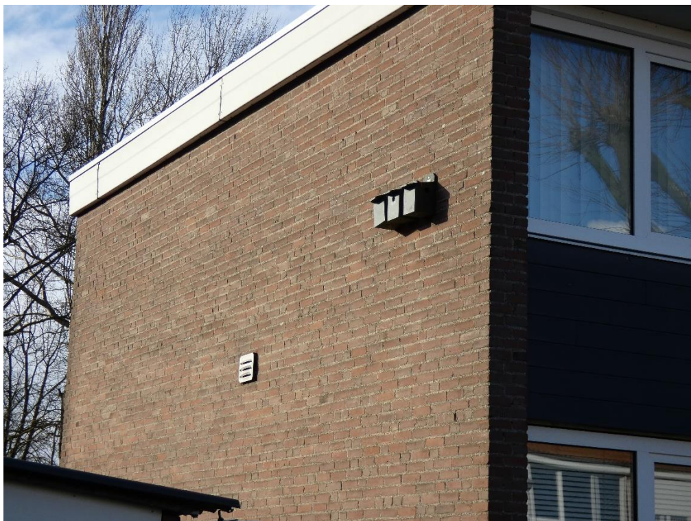
Figuur 3: Huismuskasten woning Lambertusstraat 39 (fase 2).
