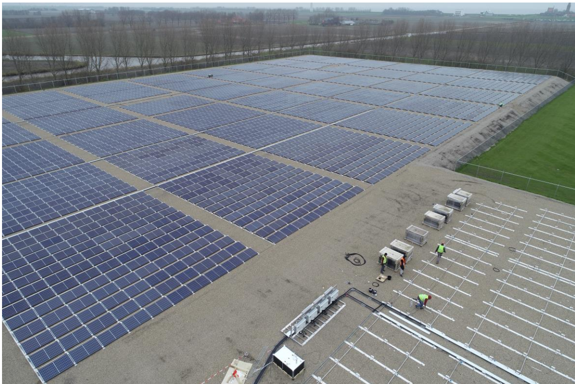
Figuur 2.6 Voorbeeldproject zonnepark op een stortlocatie.
