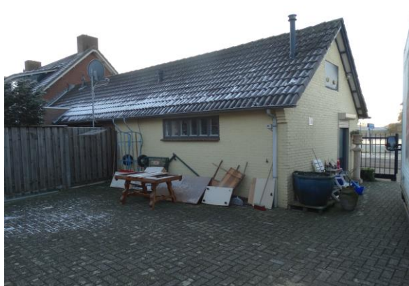
Figuur 8: De te slopen woning deelgebied 2
