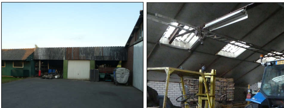
Figuur 21: Foto's te slopen bebouwing
