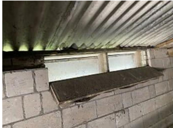
ventilatiegaten oude stal
