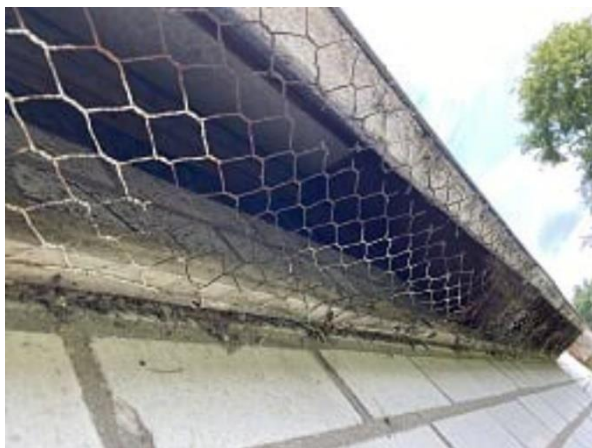
Ventilatiegaten dicht met gaas
