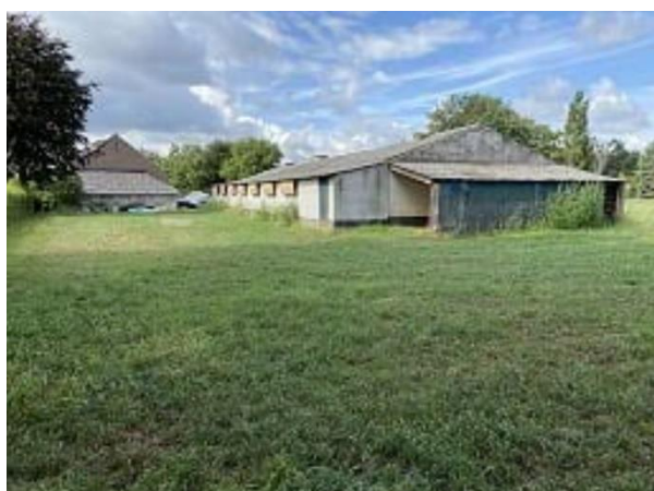
Overzicht stal en bouwplaats
