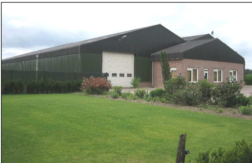
Figuur 9. Foto van de loods die thans aanwezig is en in huidige vorm en omvang behouden blijft aan Zitterd 61 Soerendonk ten behoeve van de semi-agrarische activiteiten.
