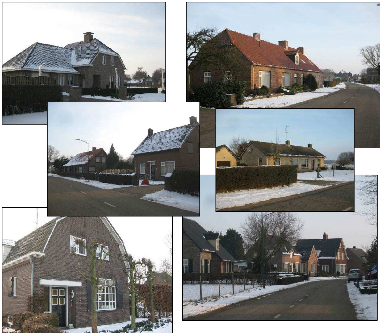
Figuur 12. Woningbouw aan de Goorstraat te Soerendonk.
