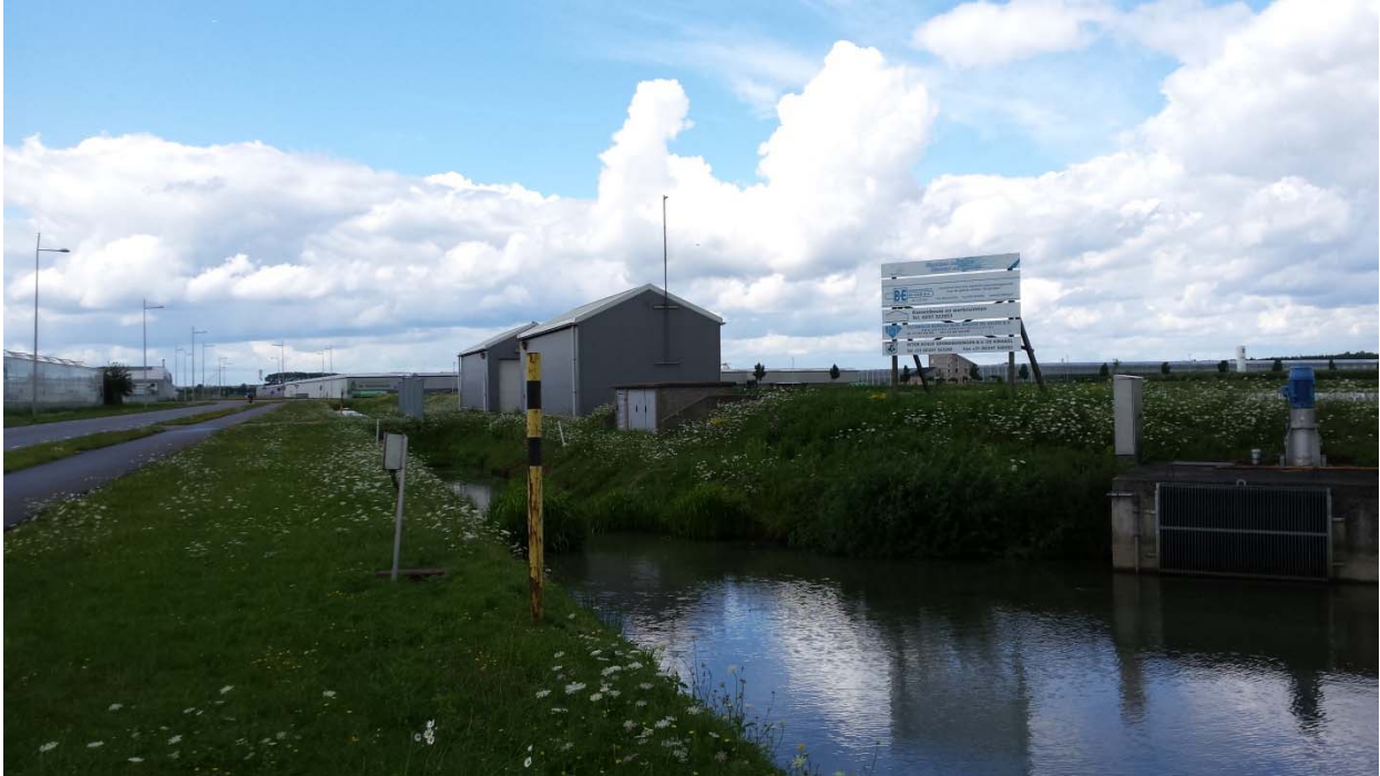
Figuur 2.4: het inlaatwerk van de bergingsvijver.
