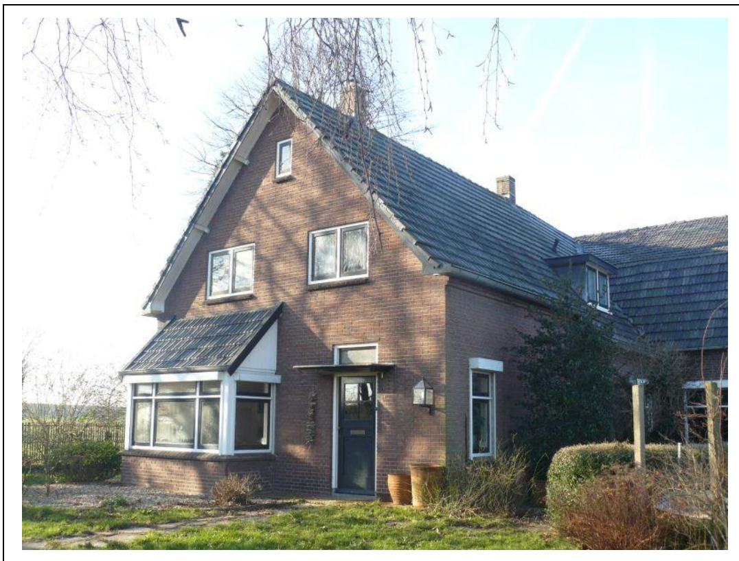
Foto 4. Onder de dakpannen kunnen huismussen nestelen en vleermuizen verblijven.
