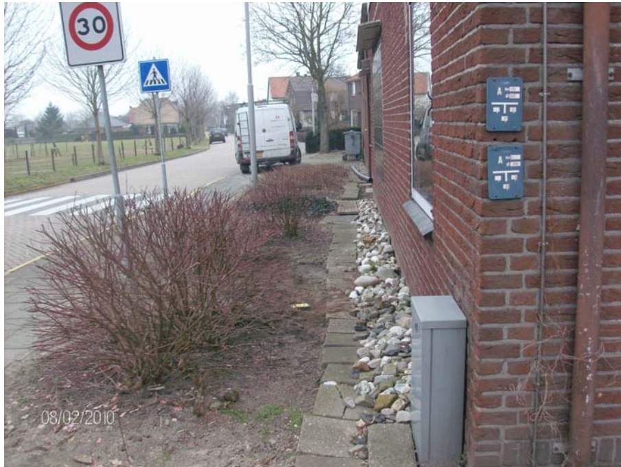
Situering peilbuis langs gevel Zandsedwardsstraat
