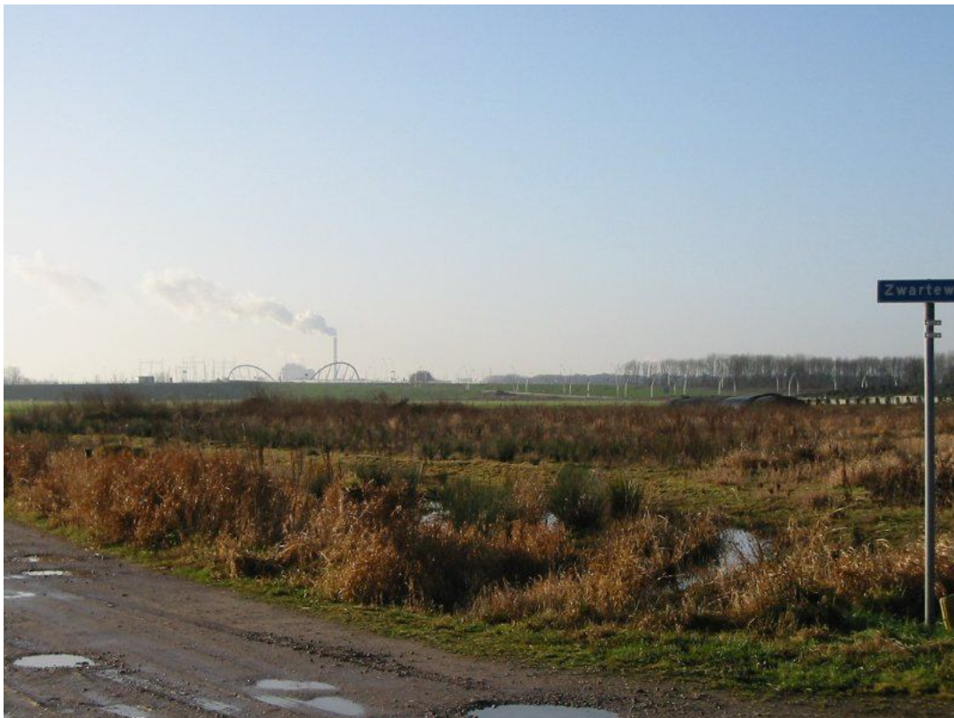
Foto Zwarte weg zuidwaards, in de verte de energiecentrale van Nijmegen, op de voorgrond het dijklichaam en de ovatonde.
