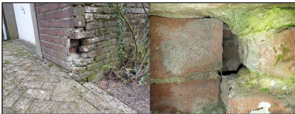
Figuur 4 Spouwmuur in de schuur op het plangebied
