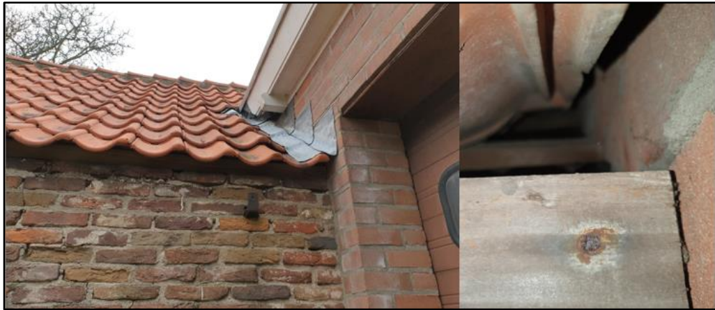
Figuur 5 Aan de onderzijde is de spouw toegankelijk via de dakpannen.
