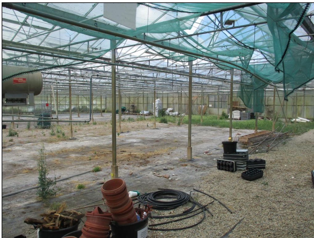
Figuur 2 De binnenzijde van de kas.
