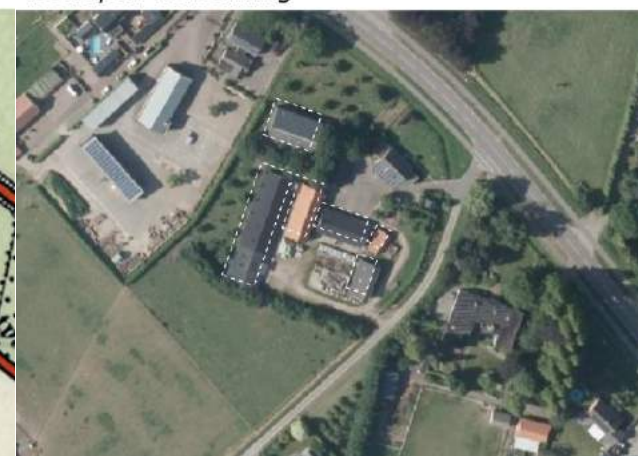
Te slopen bebouwing
