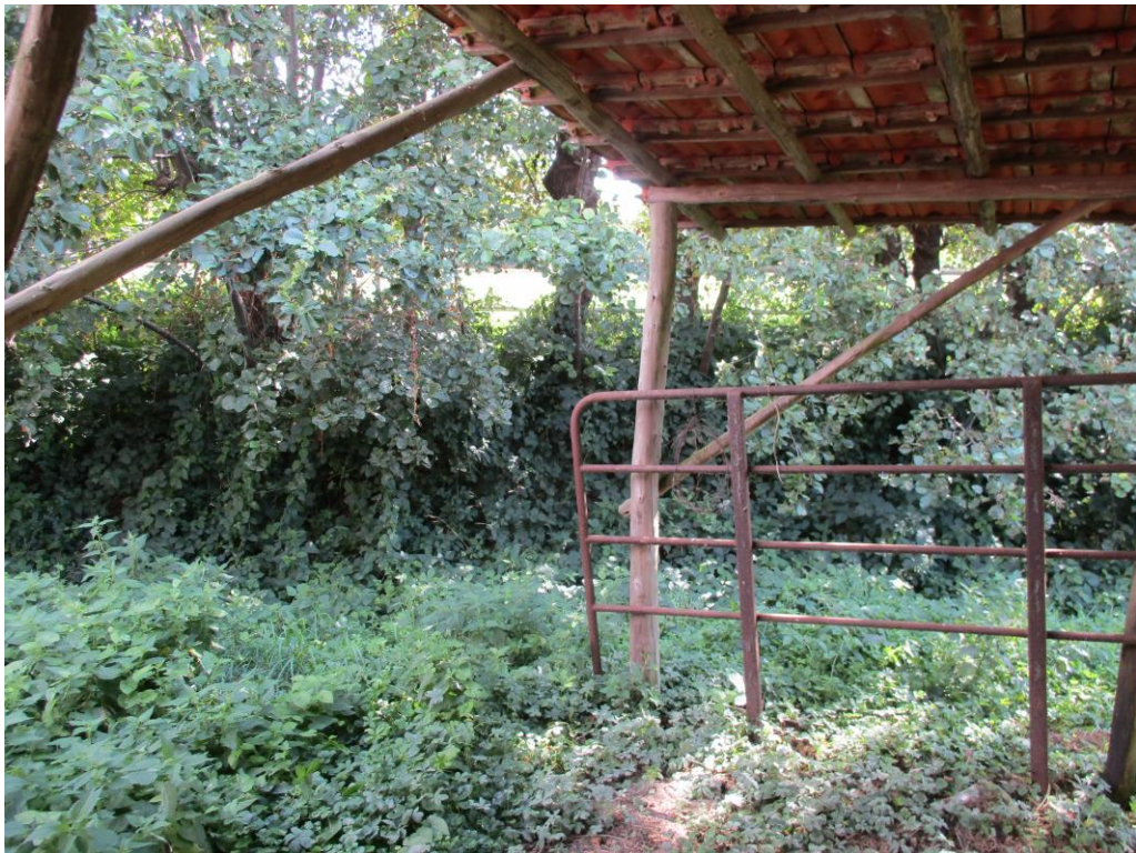
Figuur 4 De overkapping met dakpannen en met achter de houtwal.
