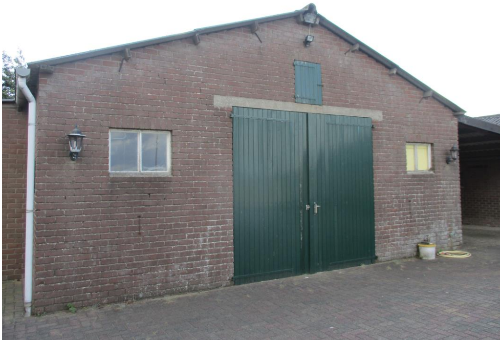
Figuur 2 De schuur met overkapping is opgetrokken uit gemetselde muren zonderspouw met een golfplaten dak.
