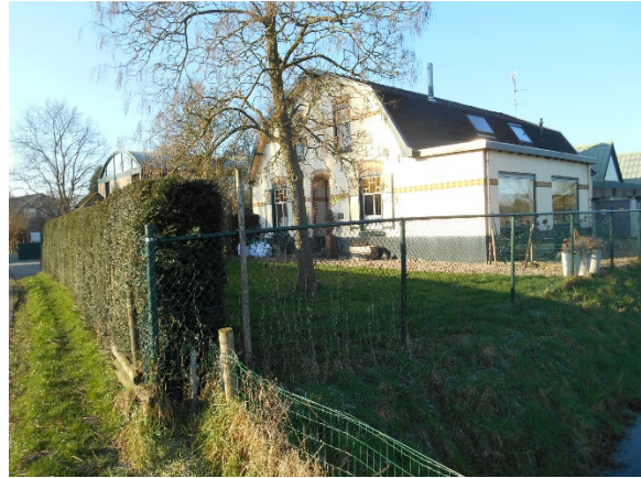
foto aanzicht bedrijfswoning vanaf de Doornenburgestraat
