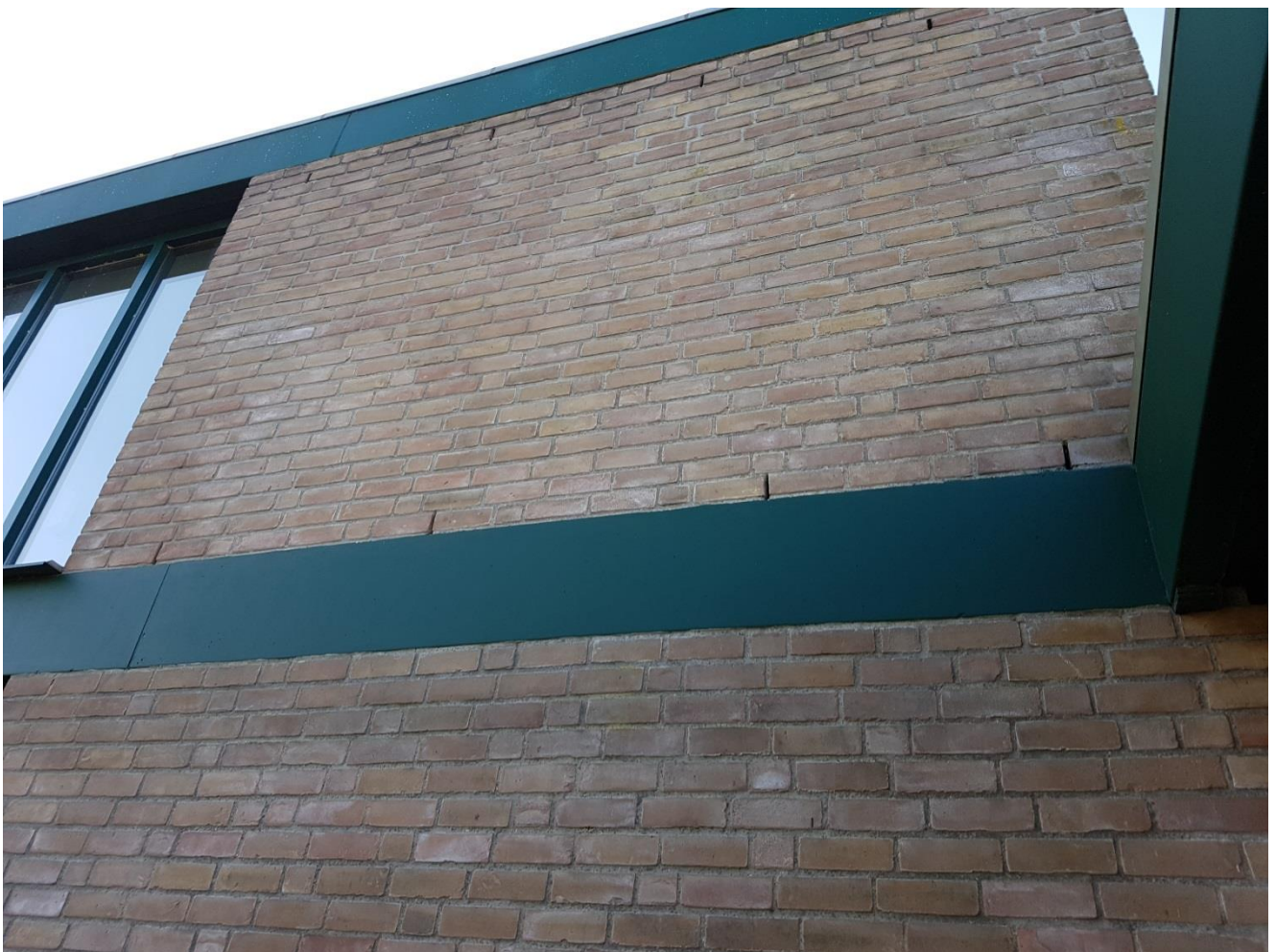
Afbeelding 3: de gevels in het gebouw hebben veel open stootvoegen die door vleermuizen kunnen worden gebruikt om toegang te verkrijgen tot de spouw die mogelijk geschikt is als voortplantings- of rustplaats voor vleermuizen.
