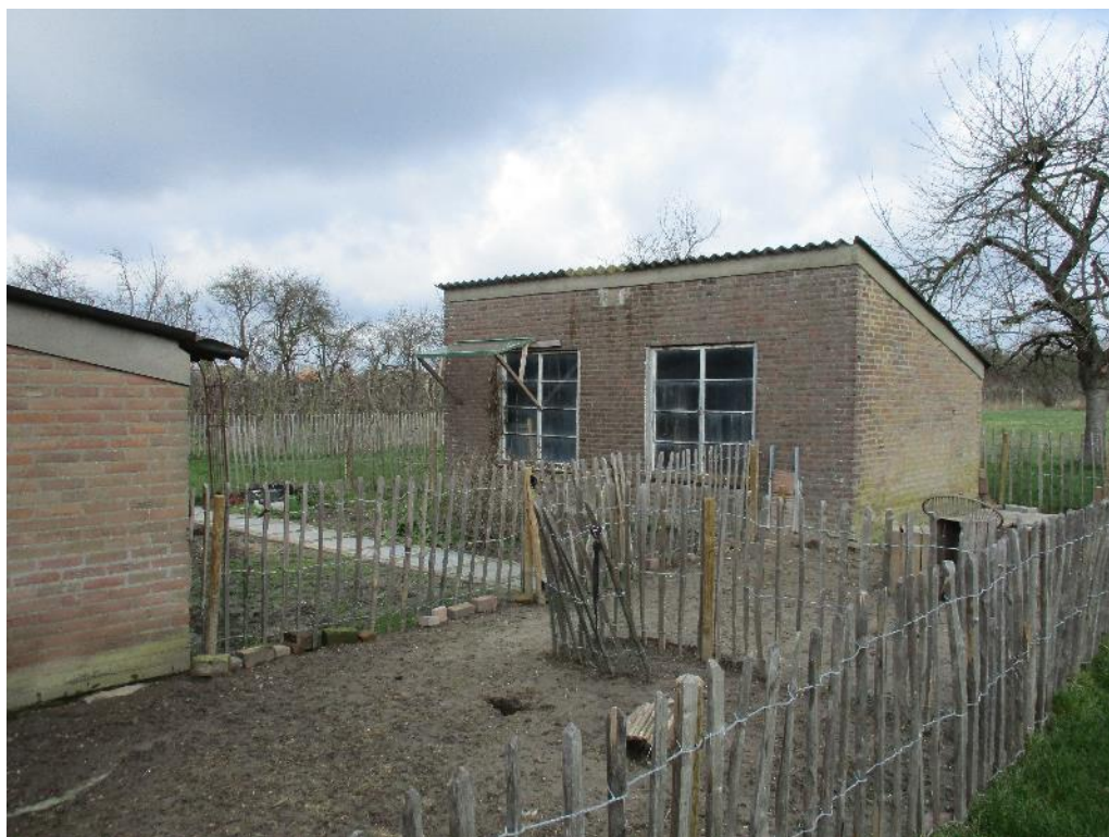
Figuur 2 Het plangebied betreft een woonperceel en een tuin met twee schuren erop gesitueerd, welke in gebruik zijnde als konijnen/kippen ren.
