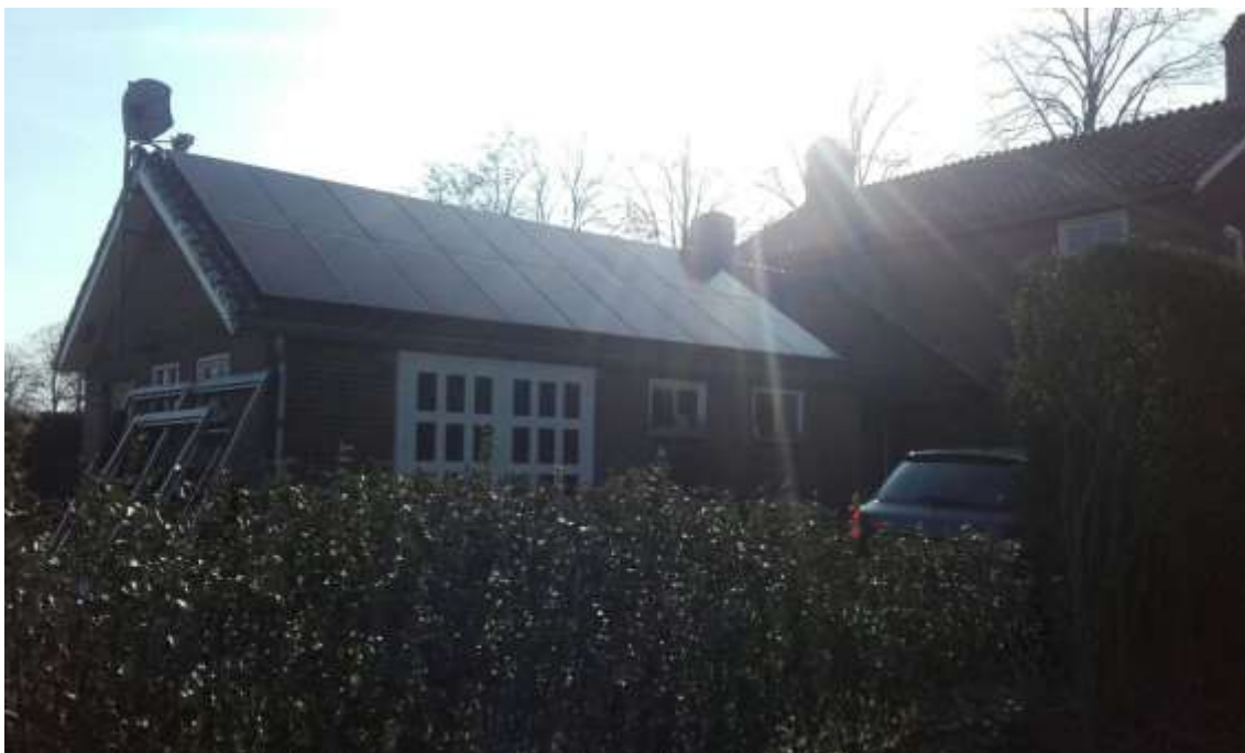
Figuur 15: Achterzijde woning Nijmeegsestraat 46
