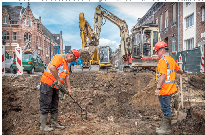
Afbeelding 6. Uitvoeren actieve analoge oppervlakedetectie m.b.v. Vallon VMM/ VMH3CS non Ferrous Locator en staafdiagram waarop het maximale detectiebereik (m1 – mv) per kaliber is aangegeven.
