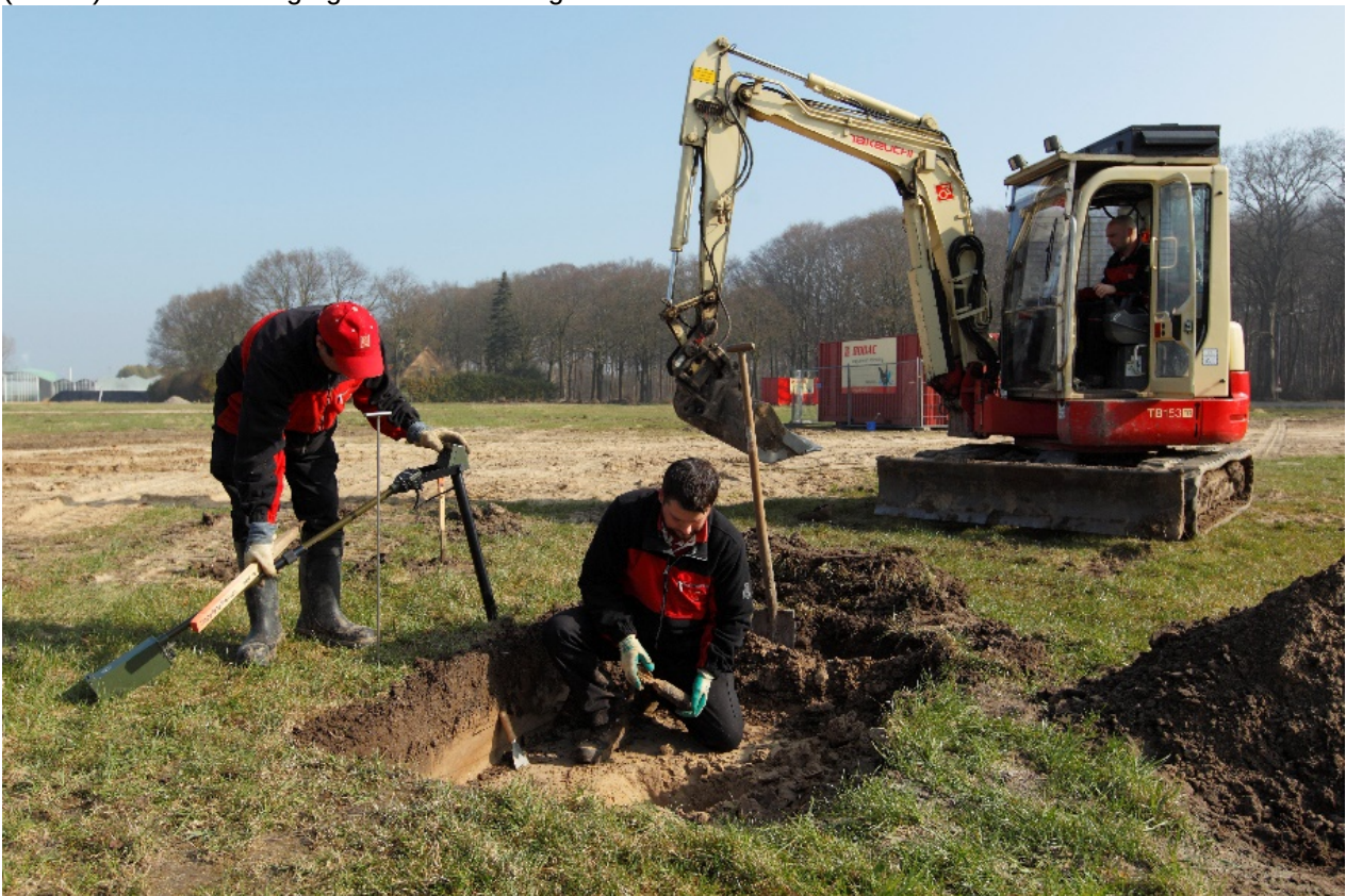
Afbeelding 4. Benaderen objecten m.b.v. beveiligde graafmachine.
