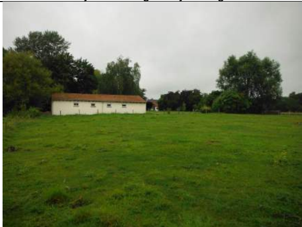
Vanuit zuidelijke richting nabij boring 7
