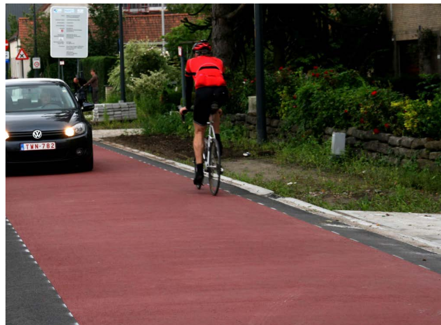
Voorbeeld van een zowel voor auto's als voor fietsers bruikbare ontsluitingsweg (hier in de vorm van een zogenaamde fietsstraat).
