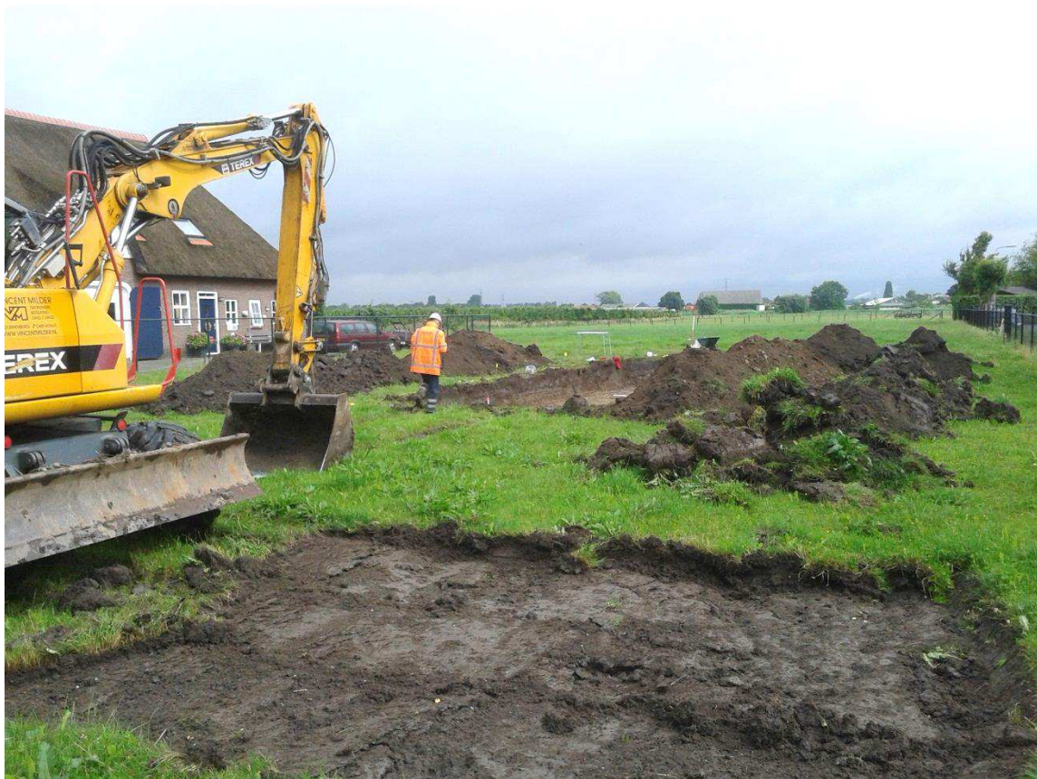
Afbeelding 1 Doornenburg-Duisterestraat 30a. Aanleg proefsleuven tijdens de eerste fase van het onderzoek gezien naar het noorden. Bron: foto Vestigia (29-06-2016).
