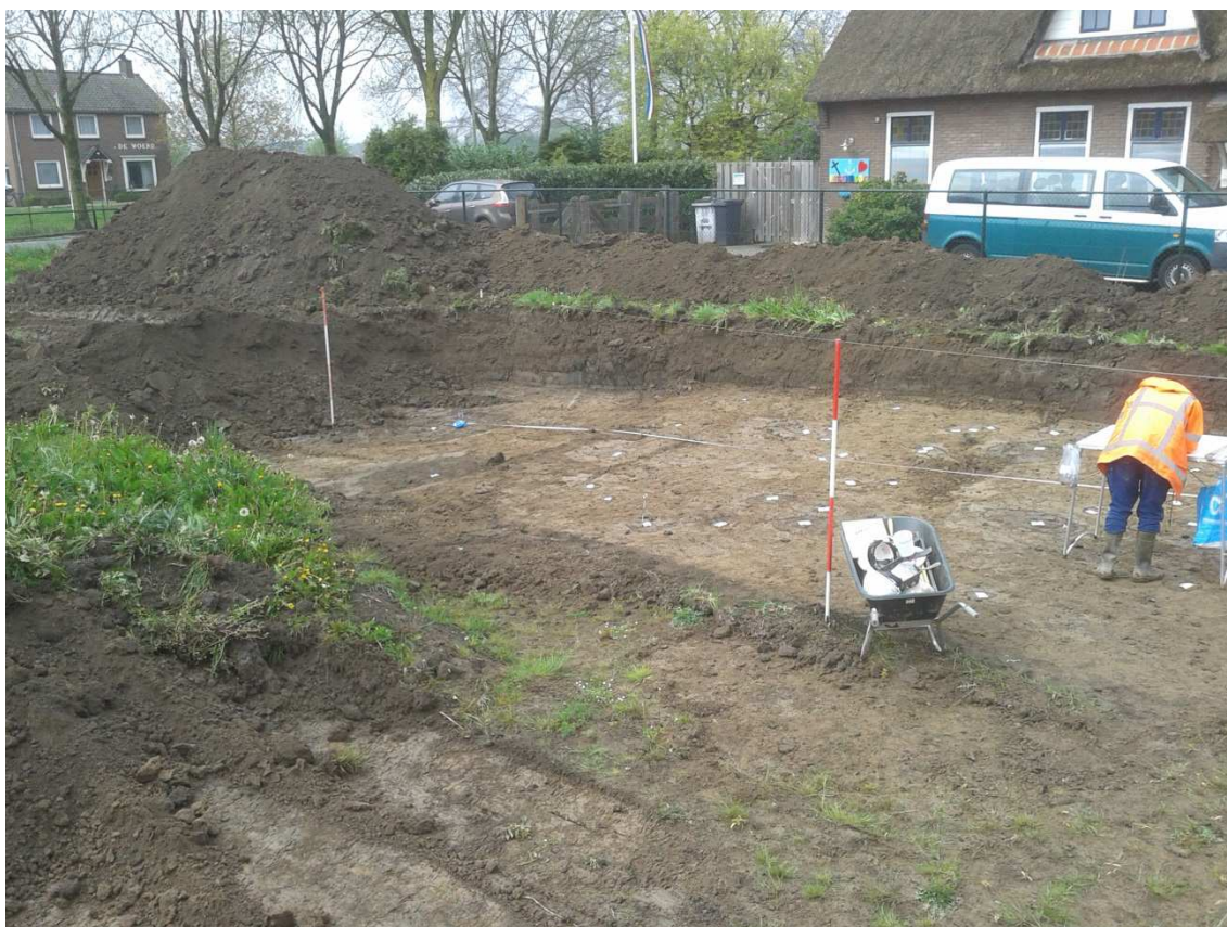
Afbeelding 2 De aanleg van proefput 3 tijdens de tweede fase van het onderzoek, gezien naar het noorden. Het vlak is aangelegd op 10,3 m NAP. Bron: foto Vestigia (3-05-2017).
