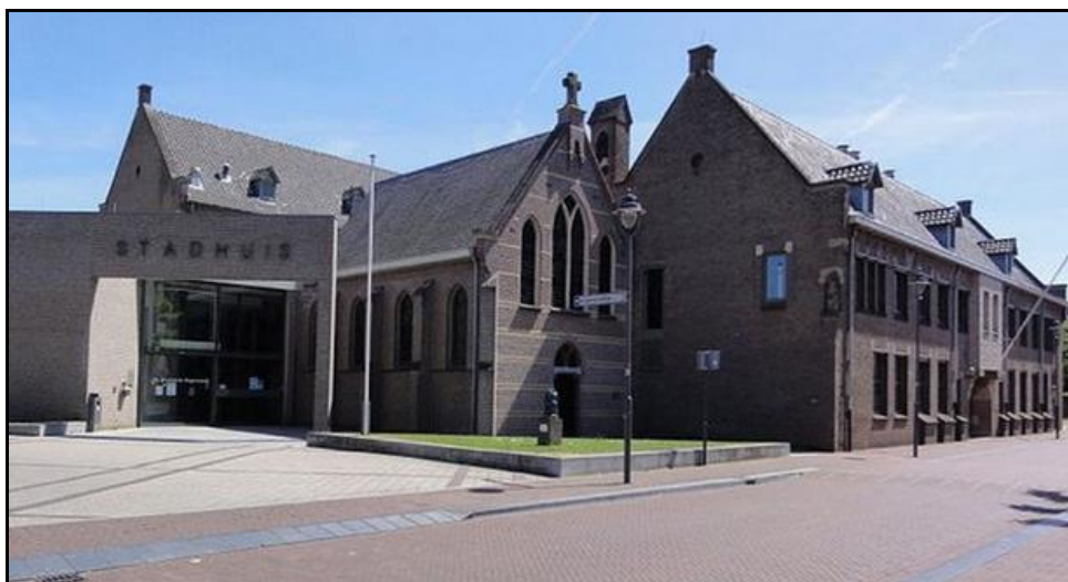
Zicht op het plangebied vanaf de Langekerkstraat in het noorden van het plangebied
