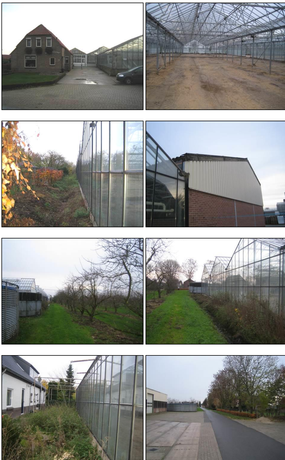
Globale indruk plangebied. V.l.n.r. Voorzijde perceel met het te behouden woonhuis aan de Hegsestraat, binnenzijde kassencomplex, zuidoostzijde kassencomplex nabij woonhuis Hogevel 1d, stenen schuur met damwandprofielen aan achterzijde van het kassencomplex (Hoge-
