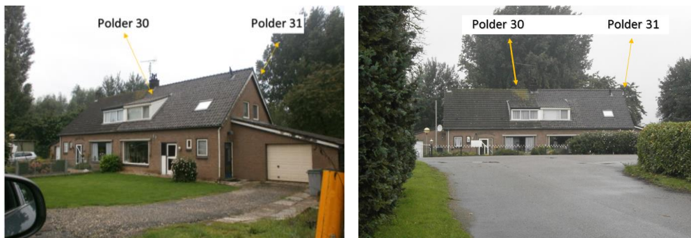
Foto's van de bestaande panden Polder 30 en 31
