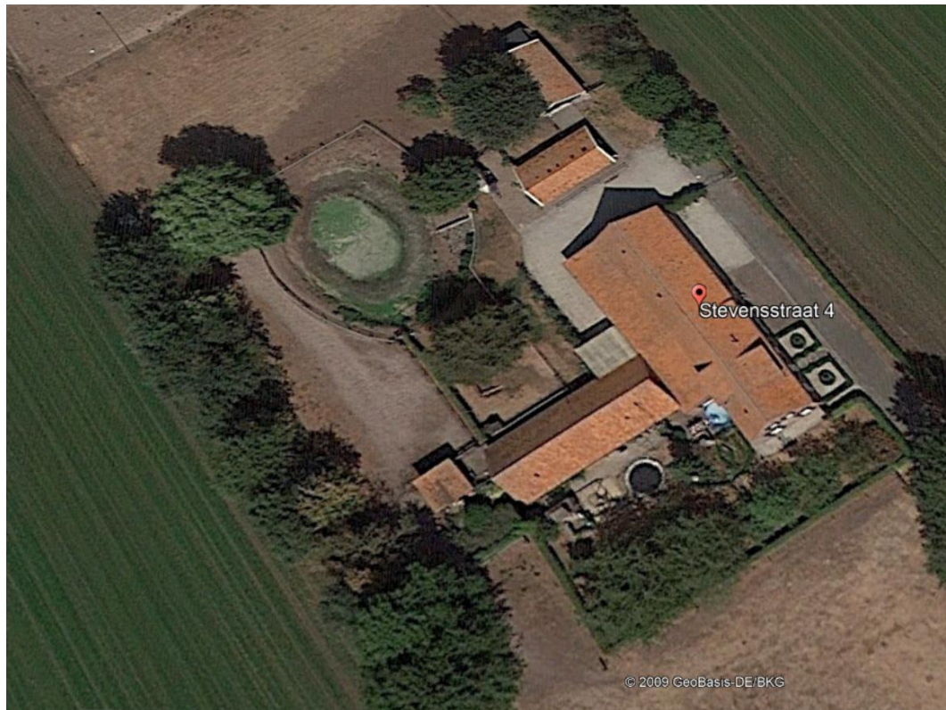
Luchtfoto (bron: Google Earth Pro)
