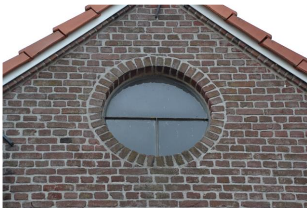
Afb. 20. Stalen rondvenster in de geveltop.
