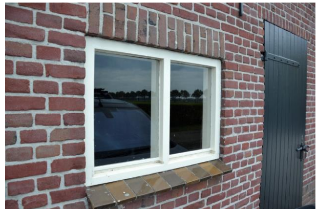
Afb. 14 en 15. Links: loopdeur met hooiluik erboven. Rechts: houten stalraam en loopdeur.
