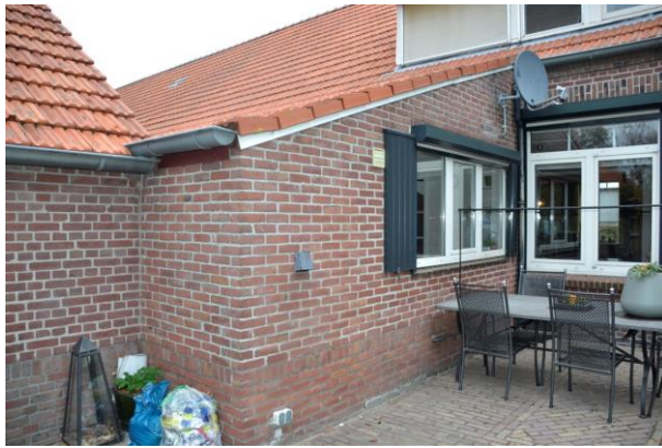
Afb. 29. Detail achtergevel met halfsteens metselwerk in de aangekapte stal.
