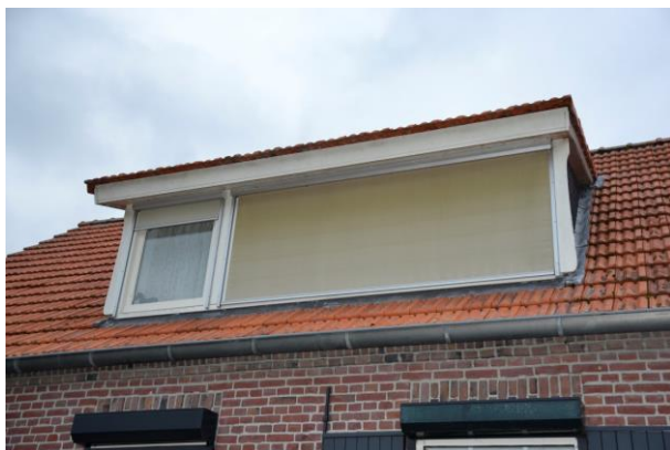
Afb. 12. Dakkapel in voordakvlak.
