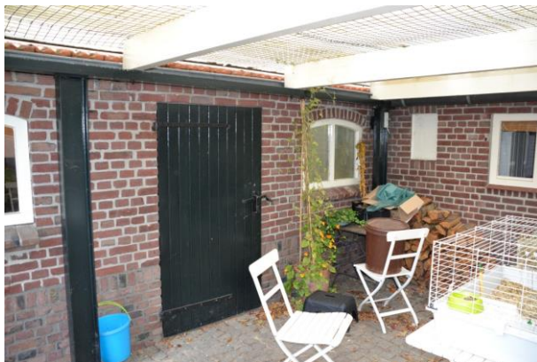
Afb. 28. Detail achtergevel bedrijfsgedeelte.
