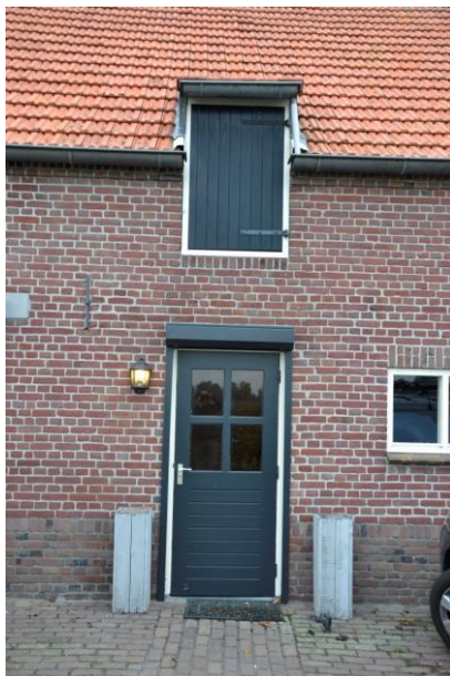
Afb. 14 en 15. Links: loopdeur met hooiluik erboven. Rechts: houten stalraam en loopdeur.
