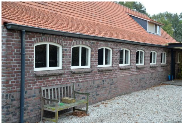
Afb. 27. Detail achtergevel bedrijfsgedeelte.
