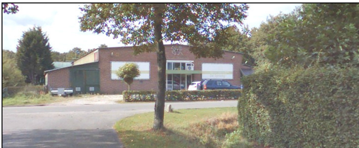
Figuur 9 Foto projectlocatie vanuit het zuidwesten
