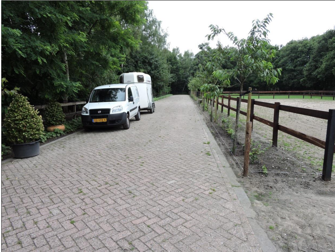
Foto 3. Vervanging van verharde toegangsweg.
