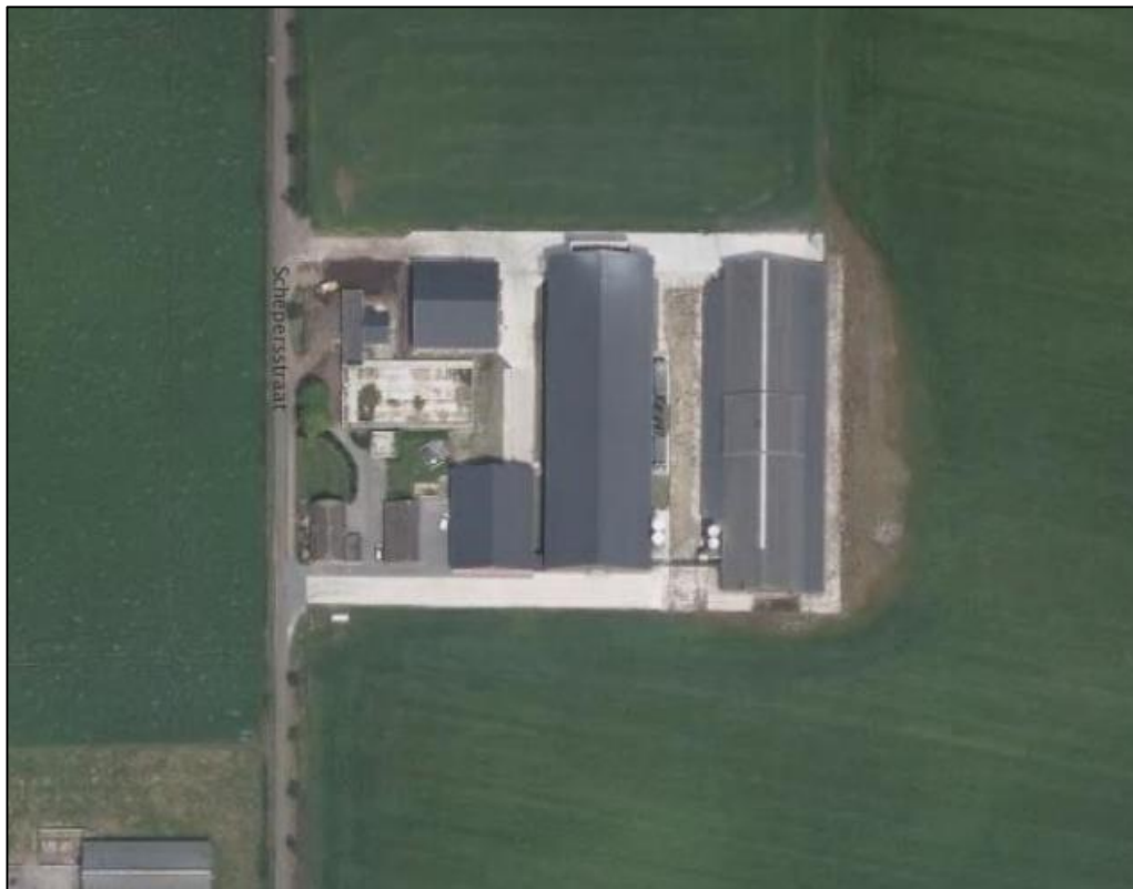
• Figuur 2, luchtfoto perceel
