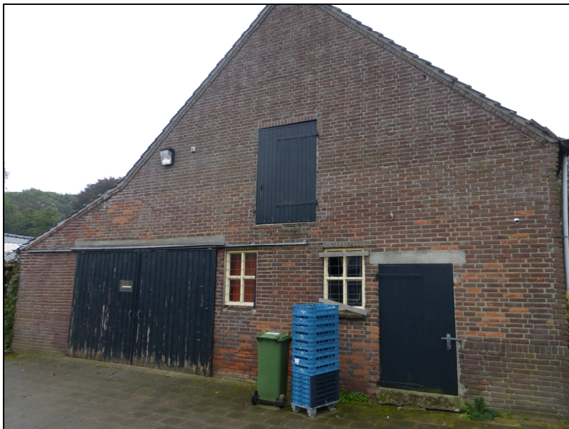
Figuur 4: Foto van de langgevelboerderij aan Mullemsedijk 8
