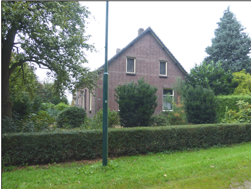
Figuur 3: Foto van de langgevelboerderij aan Mullemsedijk 8
