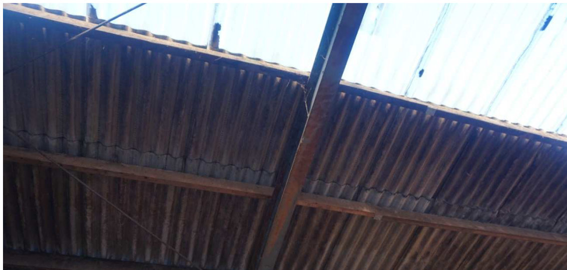
Figuur 5.3. Kapconstructie inpandige rijhal.
