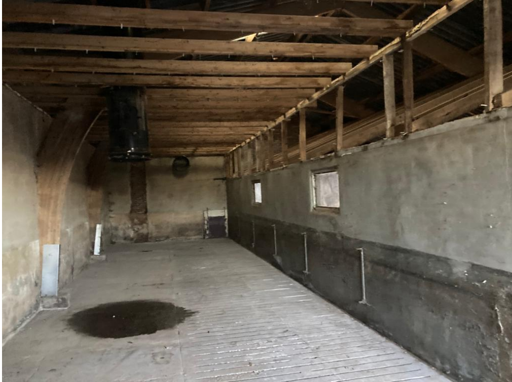
• Afbeelding 23: binnenzijde te slopen stal (reeds ontmanteld)
