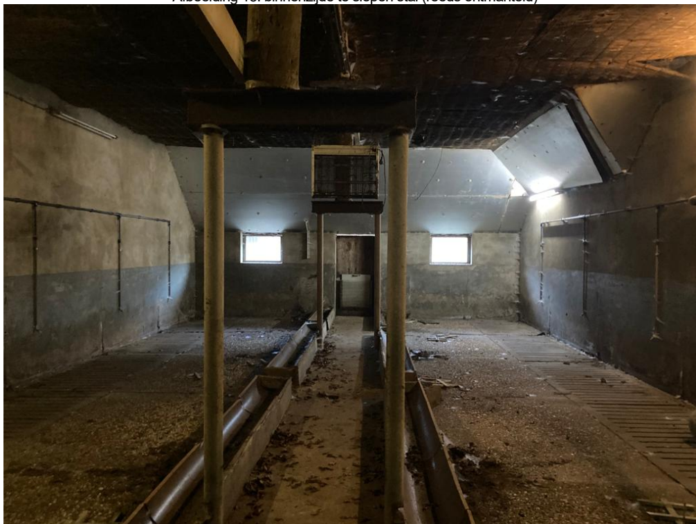
• Afbeelding 15: binnenzijde te slopen stal (reeds ontmanteld)
