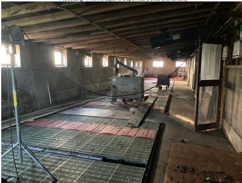
• Afbeelding 17: binnenzijde te slopen stal (reeds ontmanteld)
