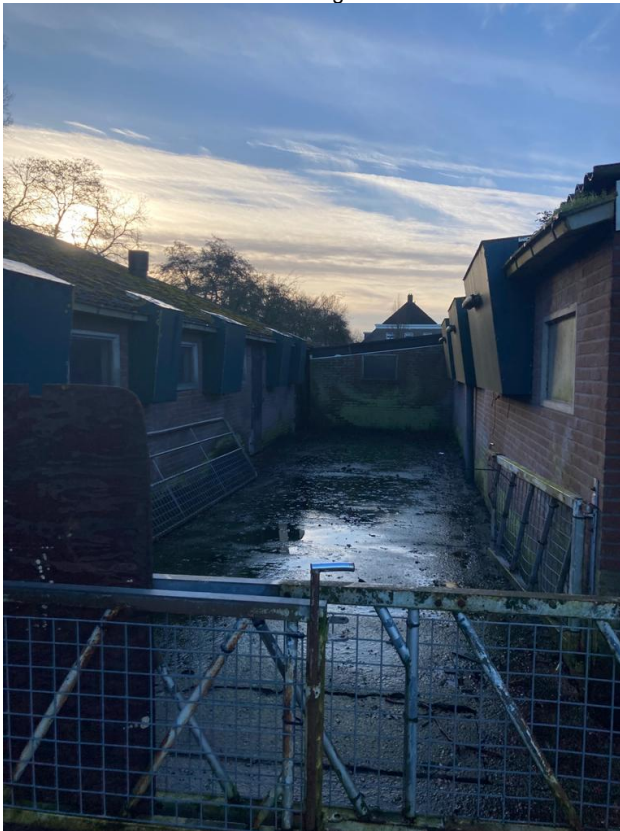
• Afbeelding 28: ruimte tussen de stallen
