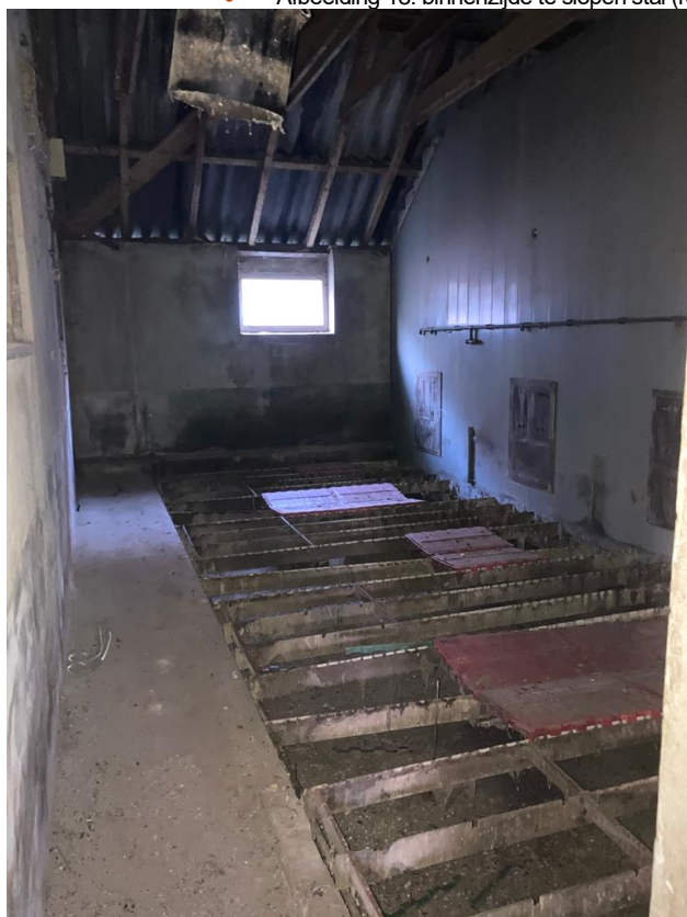
• Afbeelding 18: binnenzijde te slopen stal (reeds ontmanteld)
