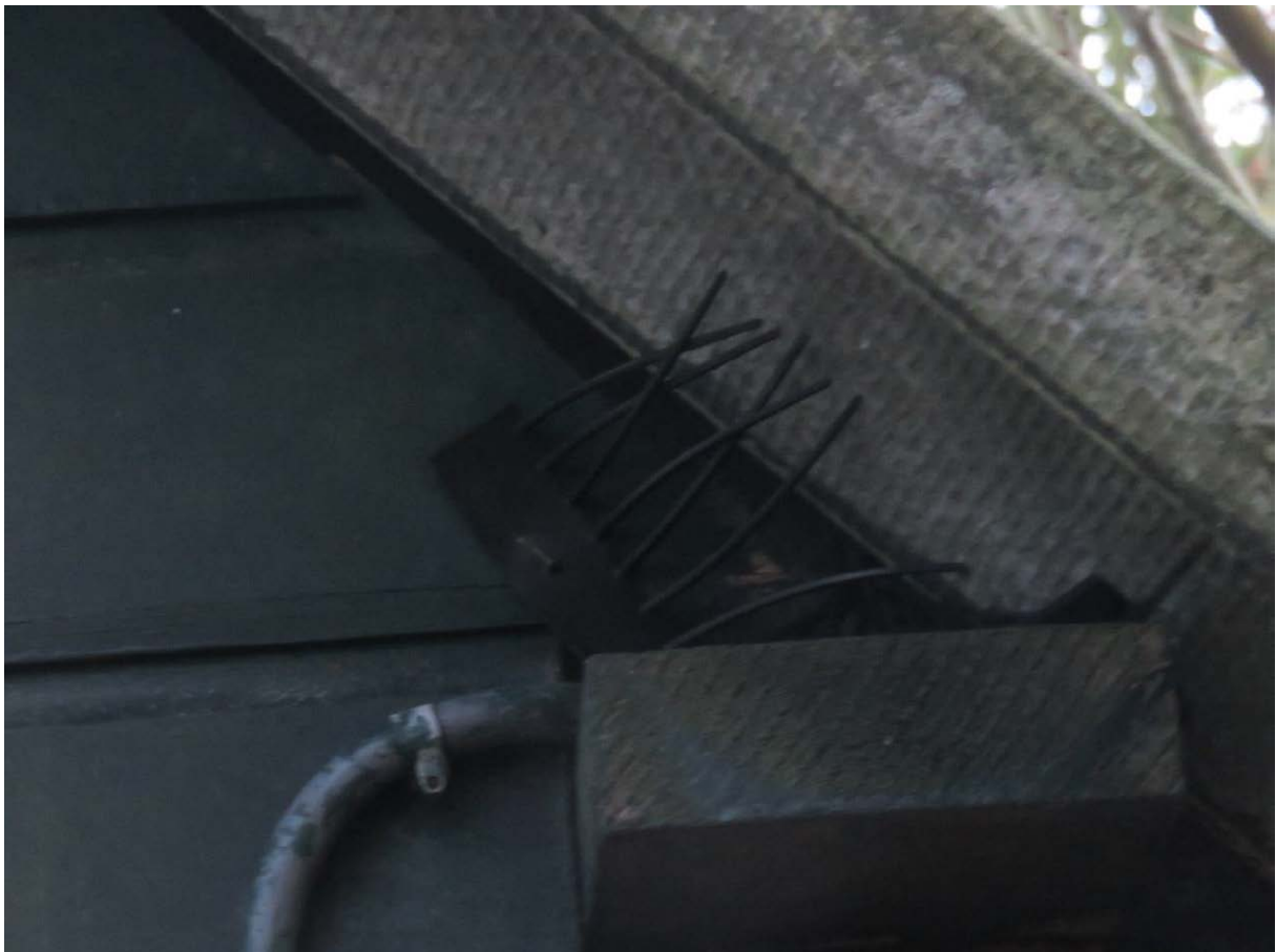
Figuur 2.3. Vogel-werend materiaal aan het uiteinde van de gegolfde dakplaten van een sanitair gebouw.
