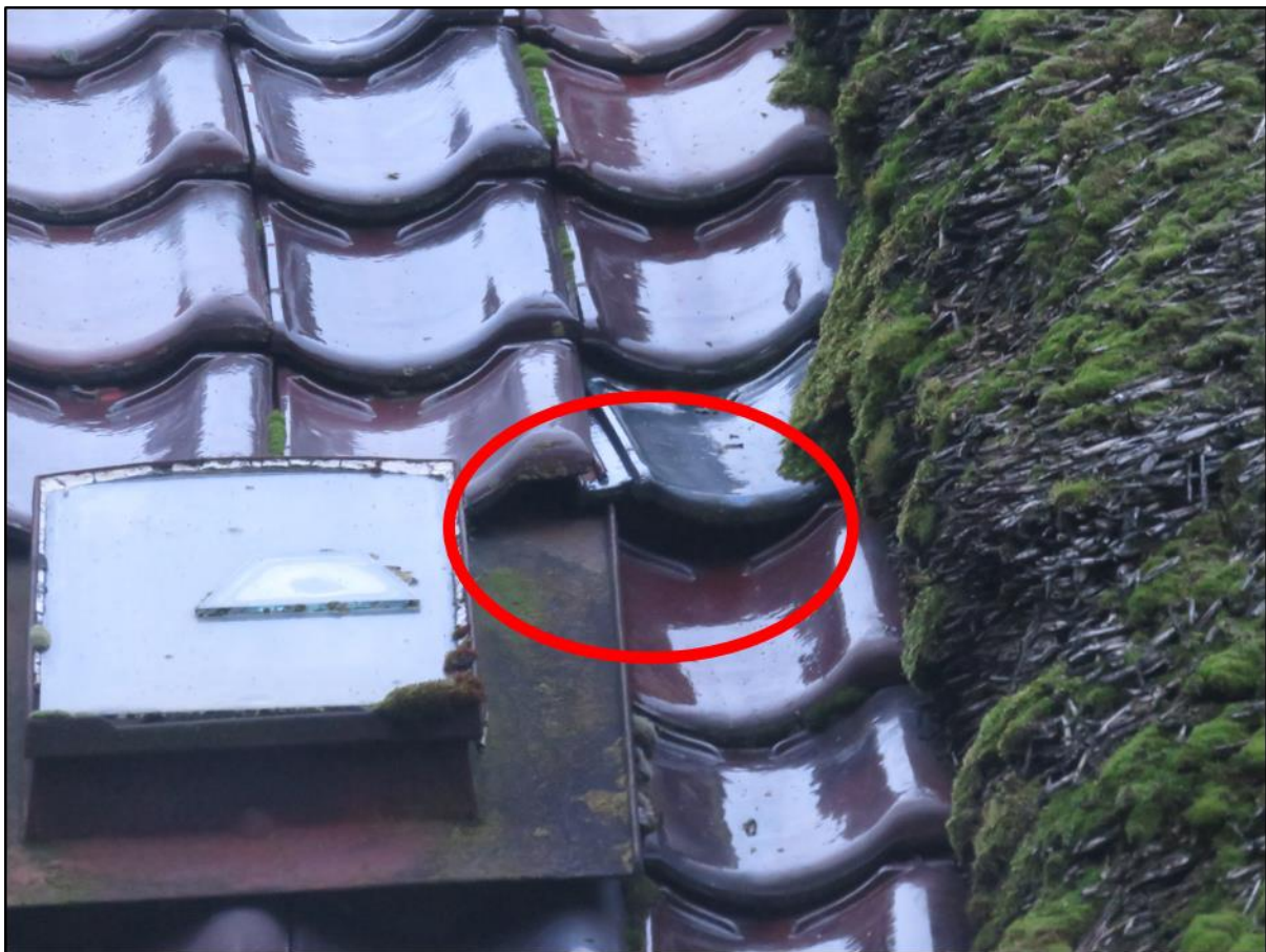
Figuur 2.4. Geschikte doorgang voor huismussen tussen de gegolfde dakpannen van de te handhaven woning.
