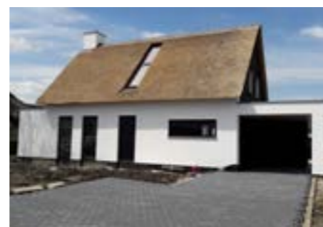
Toepassing van riet op een dak
