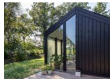
Bijgebouw met houten gevel
