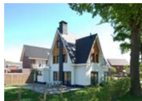
Zadeldak met houten topgevel
