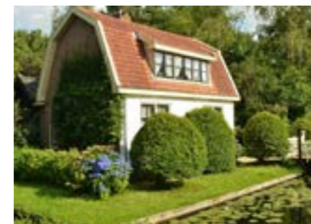
Woning met mansardedak en dakkapel
