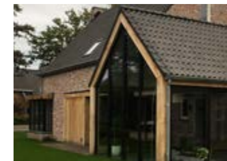
Houten bijgebouw met zadeldak
