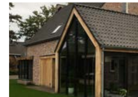
Houten bijgebouw met zadeldak
