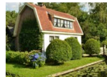
Woning met mansardedak en dakkapel
