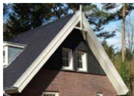
Zadeldak met houten topgevel
