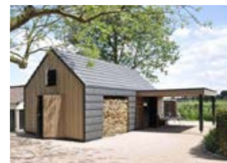
Bijgebouw met houten en pannen gevel
