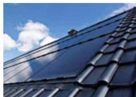
Zonnepanelen in combinatie met dakpannen
