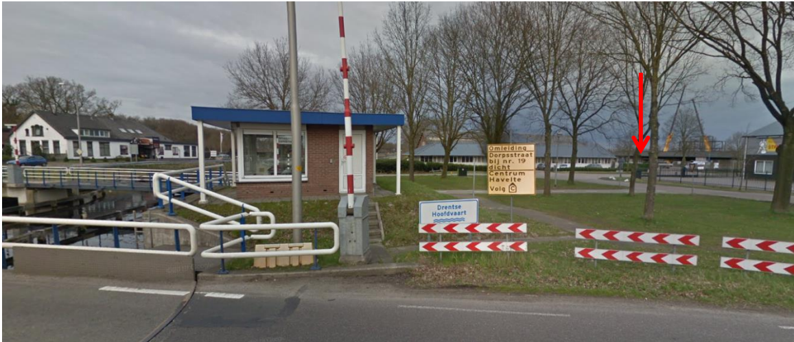
Foto 13 Zicht op onderzoekslocatie vanaf N371 (t.h.v. brug)
