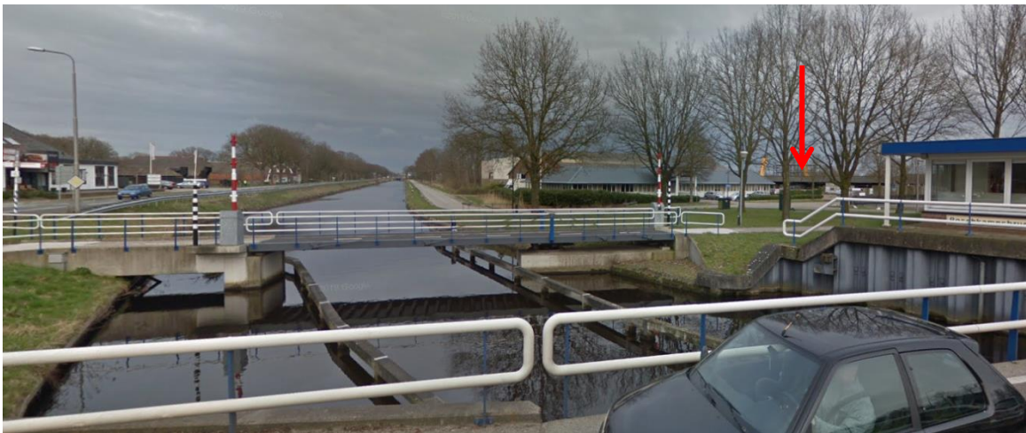
Foto 14 Zicht op onderzoekslocatie vanaf N371 (t.h.v. brug)
