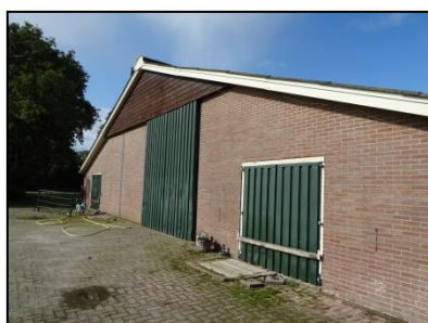
Figuur 4. Vooraanzicht van de te slopen grote stal, gezien vanuit het zuidoosten.
