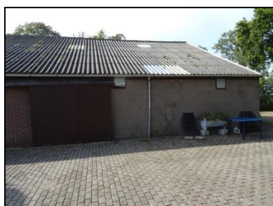
Figuur 3. Zij aanzicht van de te slopen kleine stal, gezien vanuit het oosten.
