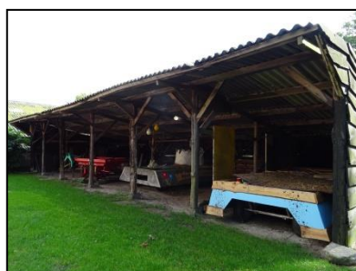
Figuur 5. De te slopen kapschuur, gezien vanuit het noordwesten.
