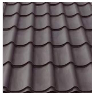
Dak Bestaande pan van hoofdgebouwd
