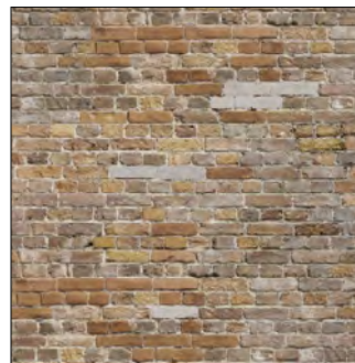
Muur Bestaand metselwerk van hoofdgebouw
