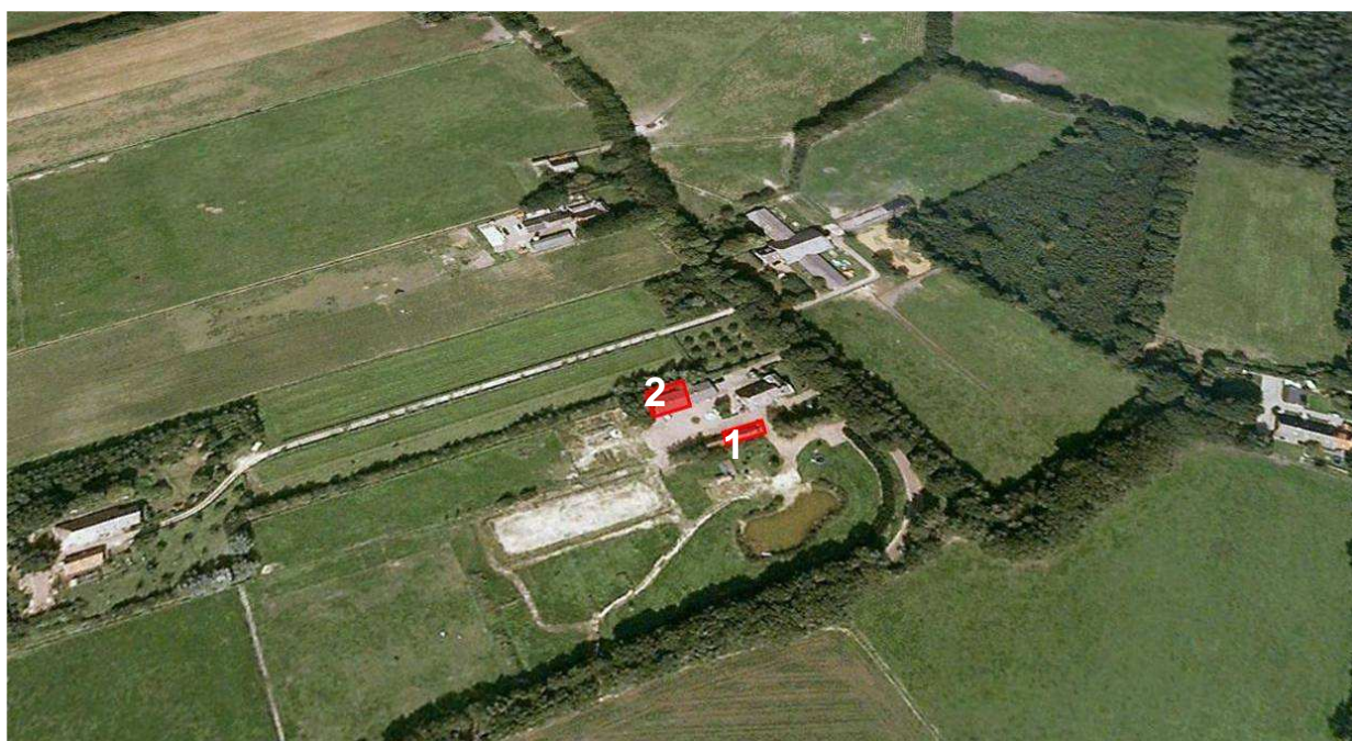
Figuur 1. Luchtfoto van de twee te slopen schuren, in rood weergegeven (Bron: Google Earth).
