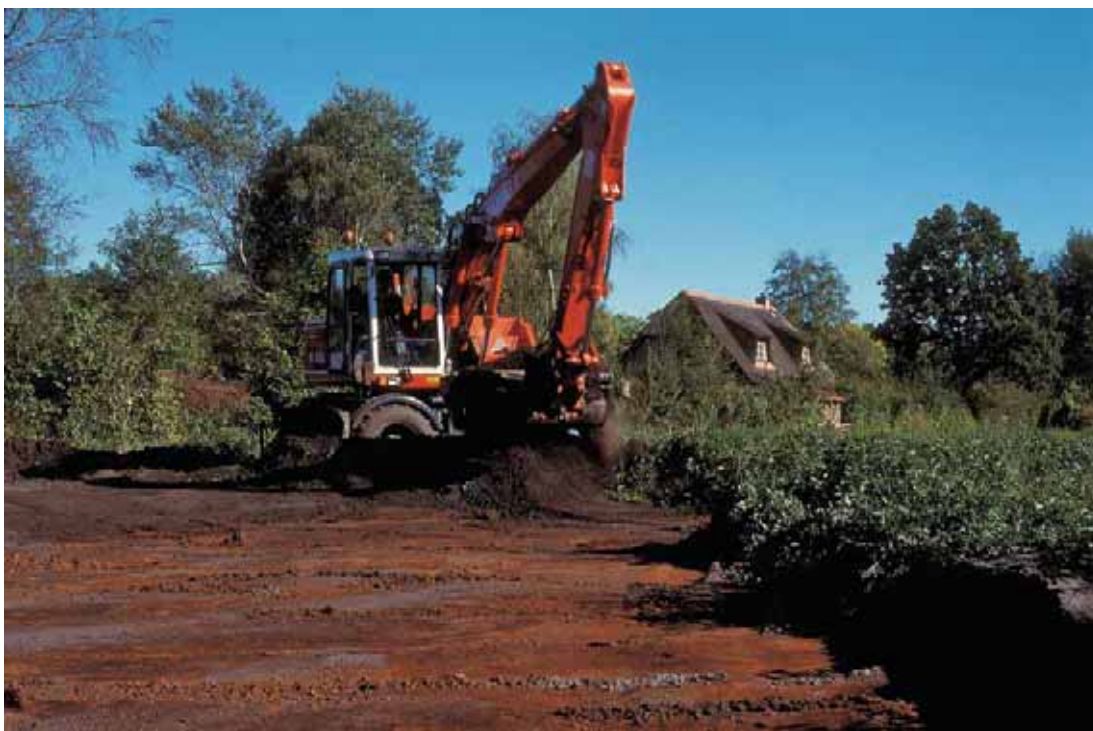
Foto 47. Een intensieve begeleiding tijdens het graafwerk is noodzakelijk voor een beter eindresultaat.
