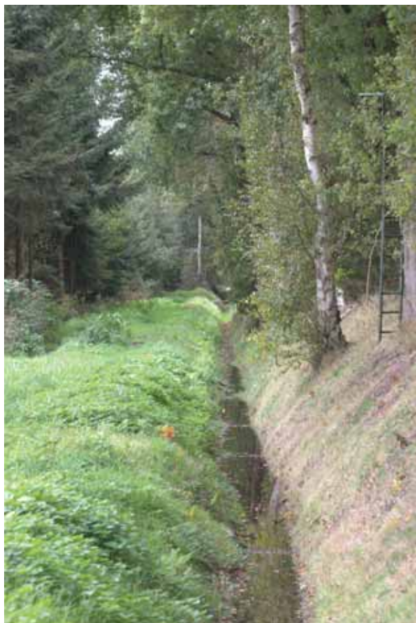
Foto 4. Waterschapssloten kunnen aantrekkelijker gemaakt worden voor flora en fauna door de oevers af te vlakken.
