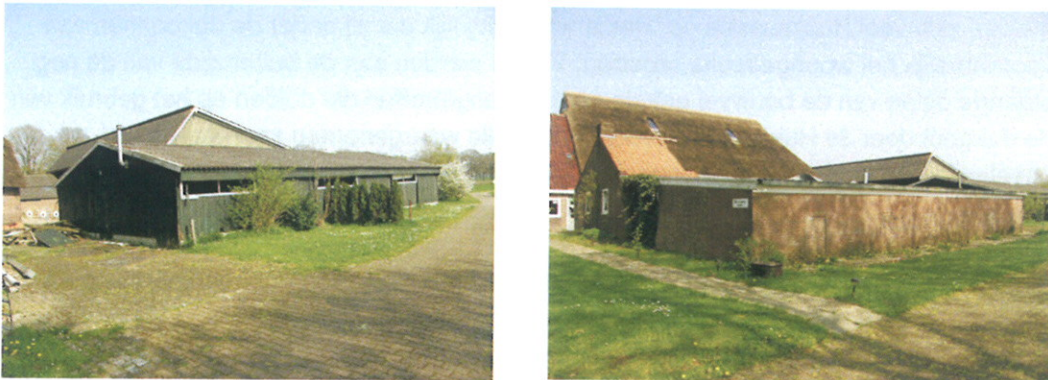
Figuur 2 Links de opslagloods op Landgoed Erica die zal worden omgebouwd tot slechtweeraaccomodatie. Rechts de recreatieruimte met op de achtergrond het woonhuis van Landgoed Erica.
