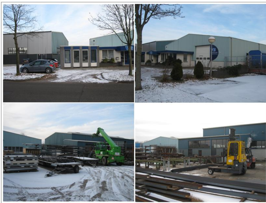
Figuur 2.3 Straatbeelden huidig perceel De Sluis 11 te Vroomshoop (Bron: Hofman Constructies B.V.)
