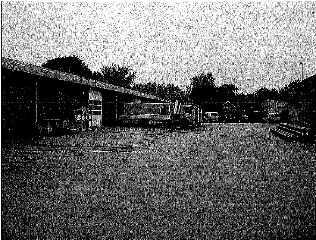
Voormalige wasplaats en voormalige en huidige ondergrondse afgewerkte olietank
