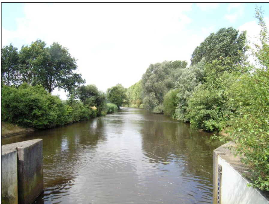
Kanaal westzijde bedrijventerrein De Sluis
