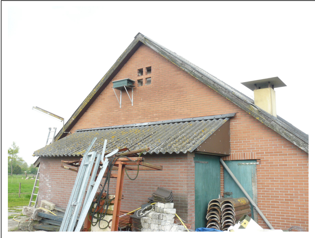
Foto 5. Steenuilenkast aan te slopen schuur Nienenhoek 19.
