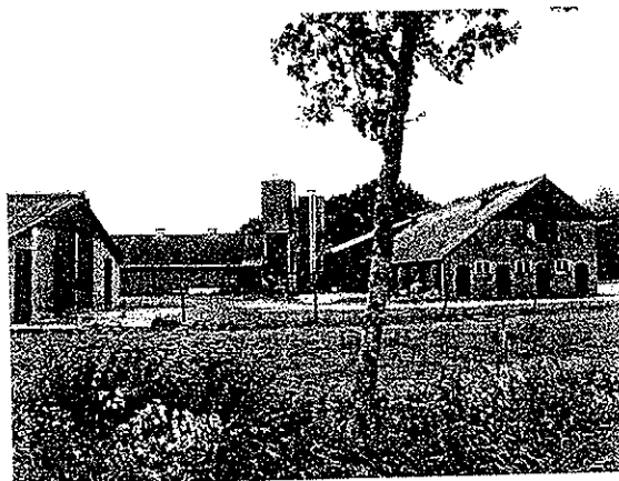
Figuur 2: Te slopen bebouwing met links de oude rundveeschuur en rechts de oude varkensschuur.
