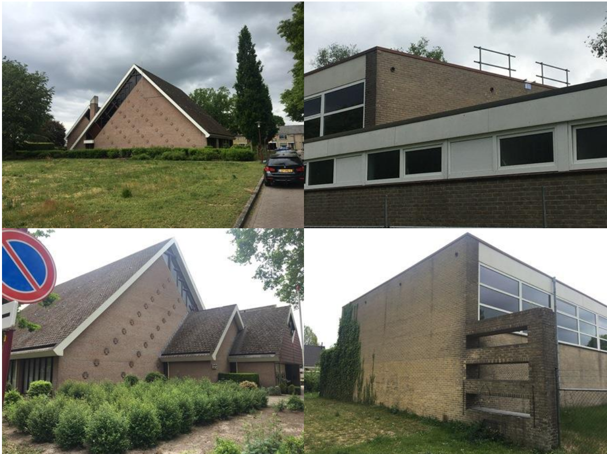
Detailopnames van de bebouwing en beplanting in het plangebied.
