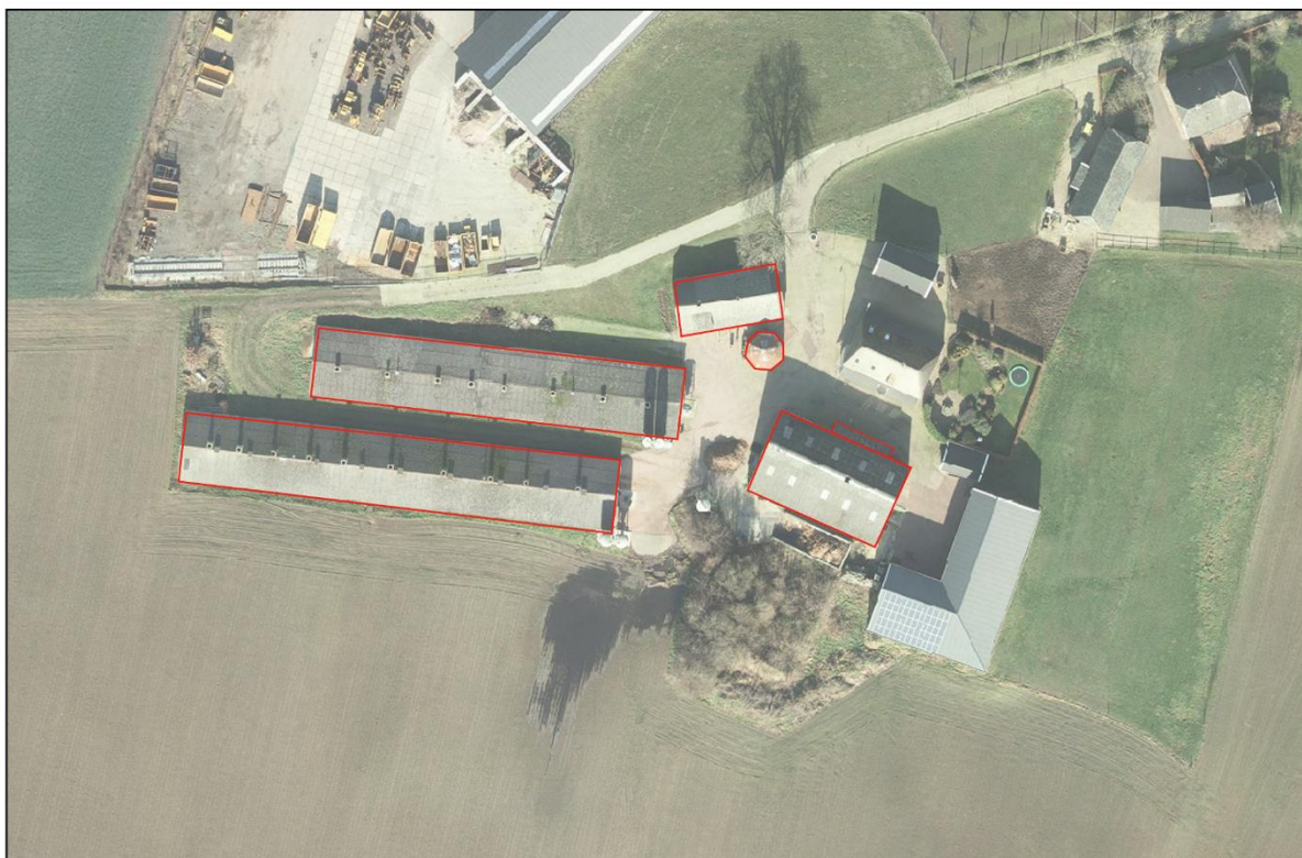
Afbeelding 3.2 Te slopen bebouwing Ommerweg 65 (Bron: Atlas van Overijssel)
