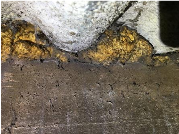
Door het afdichten van de nokken onder de golfplaten, kunnen dieren, zoals de steenmarter, niet onder de golfplaten komen.
